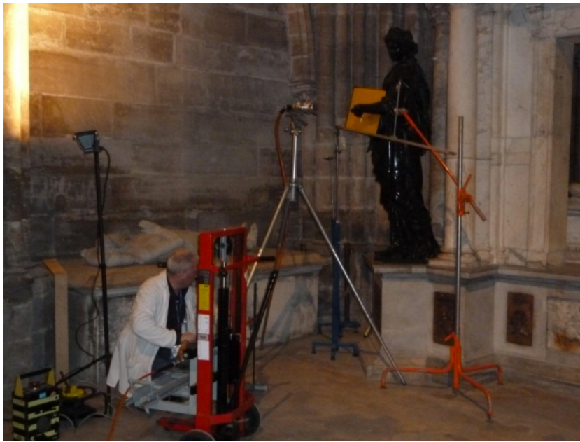
FIGURE 2.15 – Vue générale du chantier montrant le tir réalisé sur le bras gauche de la statue personnifiant la vertu cardinale de la Prudence , sur le monument funéraire d’Henri II et de Catherine de Médicis à la basilique Saint Denis. Source : Castelle (2016). © Manon Castelle.
