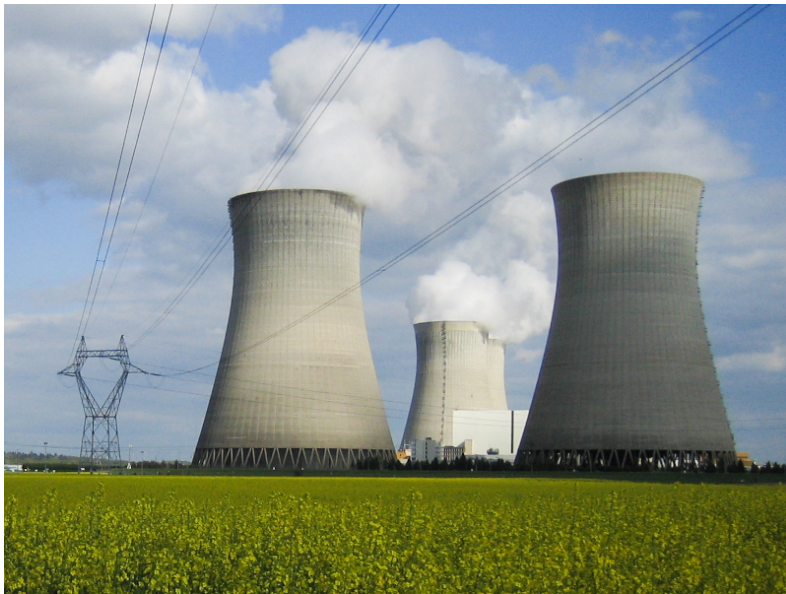
FIGURE 2.18 – Les tours aéroréfrigérantes de la centrale nucléaire de Dampierre-en-Burly dans le Loiret. Cette centrale comporte 4 réacteurs de 900 MW. Les quatre tours mesurent 165 m de haut sur une base de 131 m de diamètre. Ces tours servent de source froide, pour refroidir l'eau du circuit secondaire, afin de limiter le réchauffement du fleuve (Loire) à proximité (les centrales en bord de mer sont dépourvues de telles tours). L'eau du circuit de refroidissement (tertiaire) y est injectée sous forme de gouttelettes, l'air qui y circule du bas vers le haut (effet cheminée), se réchauffe à leur contact et se charge d'humidité. Il s'échappe par le haut, emportant quelques gouttelettes qui forment les panaches blancs que l'on peut voir. Les tours sont en béton de forme hyperboloïde pour mieux supporter le poids de l'eau qui ruisselle et pour faciliter la convection naturelle par effet Venturi. Crédit photo : Guillaume Blanc.
