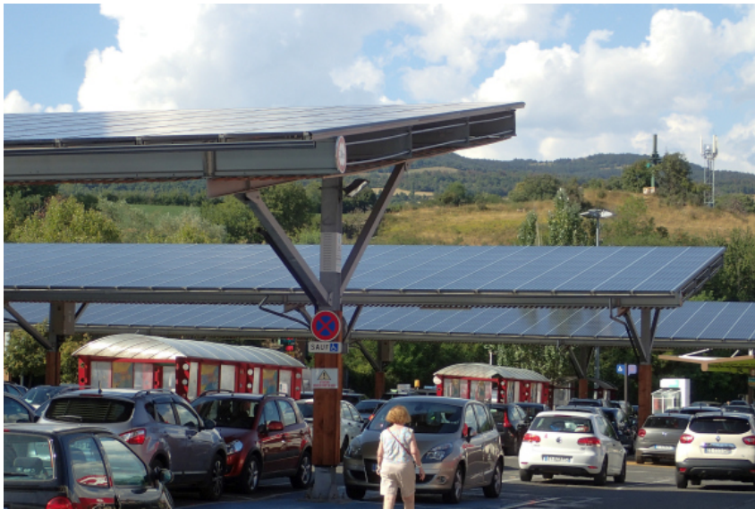
FIGURE 4.15 – Parking de supermarché couvert équipé de panneaux solaires photovoltaïques à Gap (Hautes-Alpes). Crédit photo : Guillaume Blanc.
